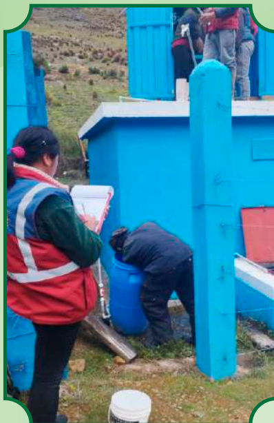
DESINFECCIÓN Y LIMPIEZA DE LOS SISTEMAS DE ABASTECIMIENTO DE AGUA
